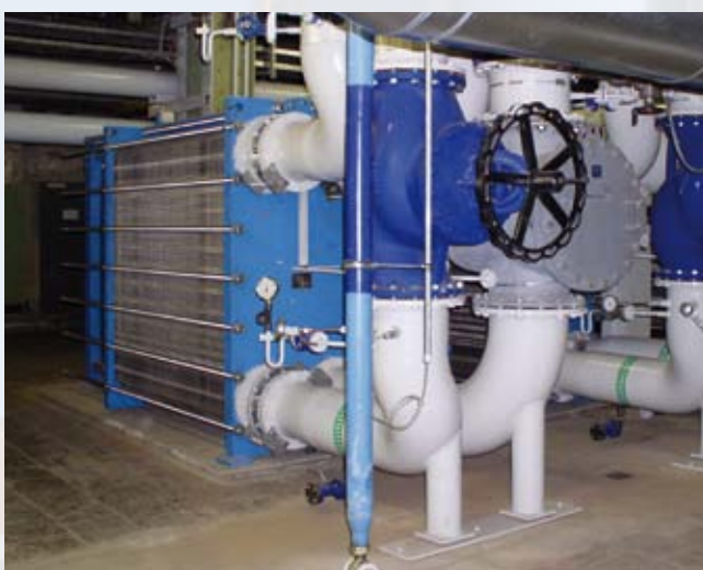
Охлаждение установок лазерной сварки в автомобильной промышленности
